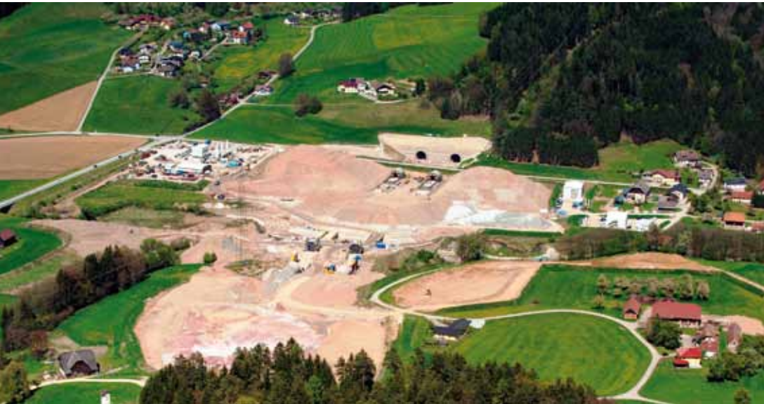
Blick auf Tunnel Deutsch Grutschen Süd und Langer Berg Nord – © ÖBB/Pachoinig
