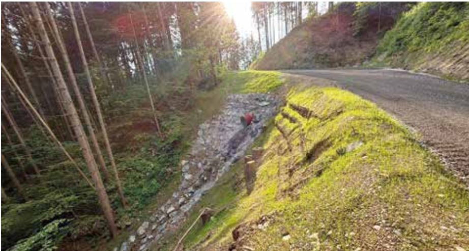
Schadensbehebung an der Gönitzstraße.
